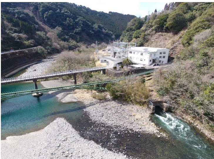
綾第二発電所 全景
